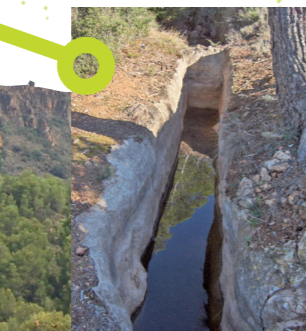
Balsa de refrigeración
